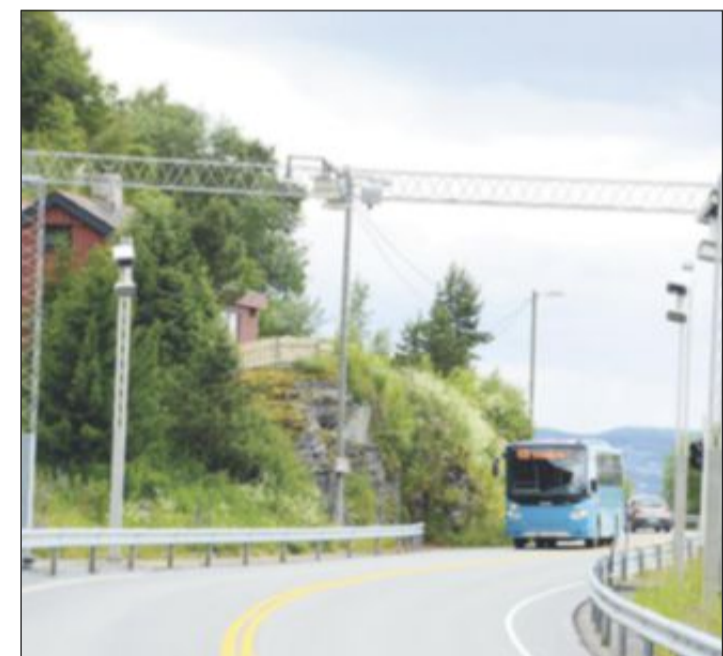
EN AV FIRE: Bomstasjonen på Øysand står ved gamle E39.
