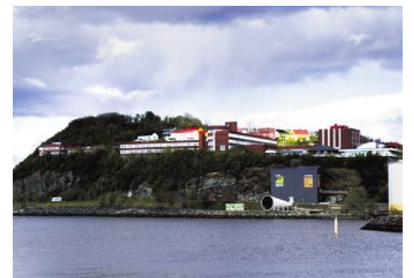
Skipssimulatorene ligger på det tidligere maritime skolesenteret på Ladehammen, men blir snart flyttet til Grilstad.
