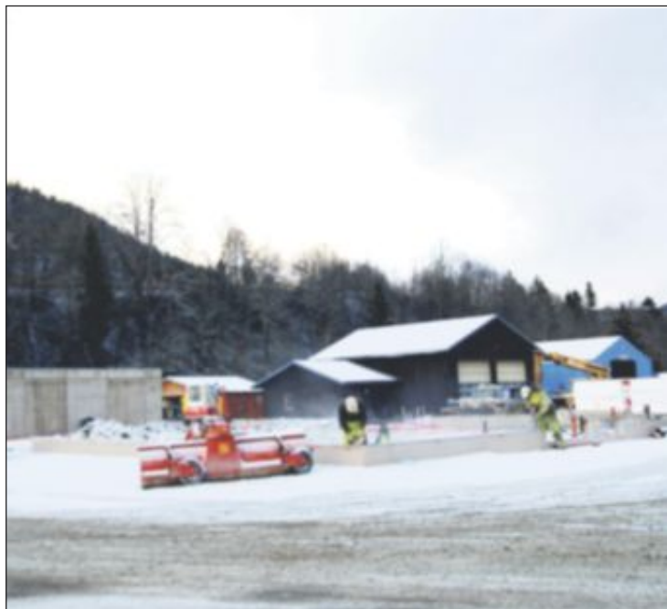
SETTER OPP NYTT BYGG: Winsnes maskin setter i dag opp et nytt bygg, rett ved siden av sitt næringsbygg på Liøya på Støren. Nybygget skal de delvis selv ta i bruk, i tillegg til at de kommer til å leie ut til andre.
