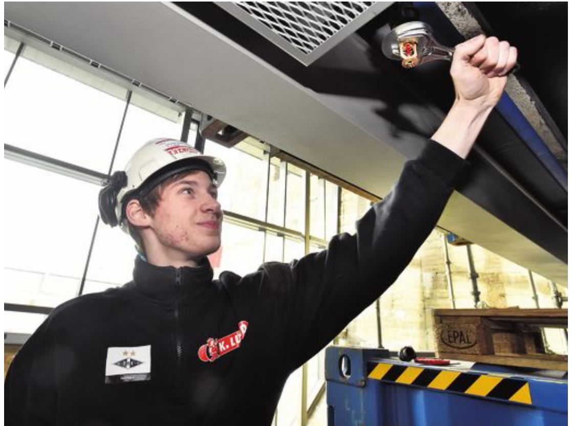
– En rekke bedrifter rapporterer at det er svært vanskelig å få dekket behovet for arbeidskraft som har en praktisk tilnærming, skriver kronikkforfatterne. Johnny Dankworth er rørleggerlærling i rørleggerfirmaet K. Lund. Han er i ferd med å gjøre ferdig kontorbygget til Trondheim Havn på Nyhavna.
