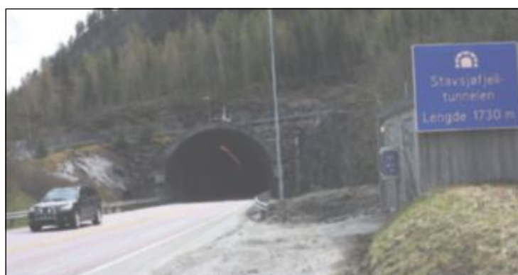
SKAL OPPGRADERES: All belysning skal blant annet byttes ut i Stavsjøfjelltunnelen. Foto: Statens vegvesen
